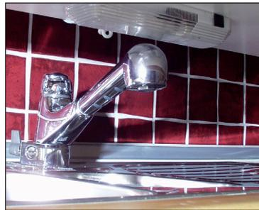
Beachten Sie die Gefahr des Zusammenstossens vom Verti und der Mischbatterie auf der Arbeitsplatte. Der Wasserhahn und dessen Bedienhebel müssen vor dem Herabfahren zur Wand gedreht werden, sonst besteht ein Quetschrisiko. (Eine Mischbatterie sollte nicht unter einem Verti geplant werden).
